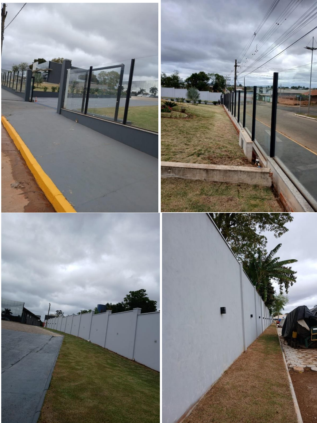
(ANEXOS 10,11,12 e 13) Nas imagens acima temos o muro de vedação da frente de vidro e os muros que cercam a lateral do imóvel feitos de alvenaria. Fonte: (Acervo do Perito).
