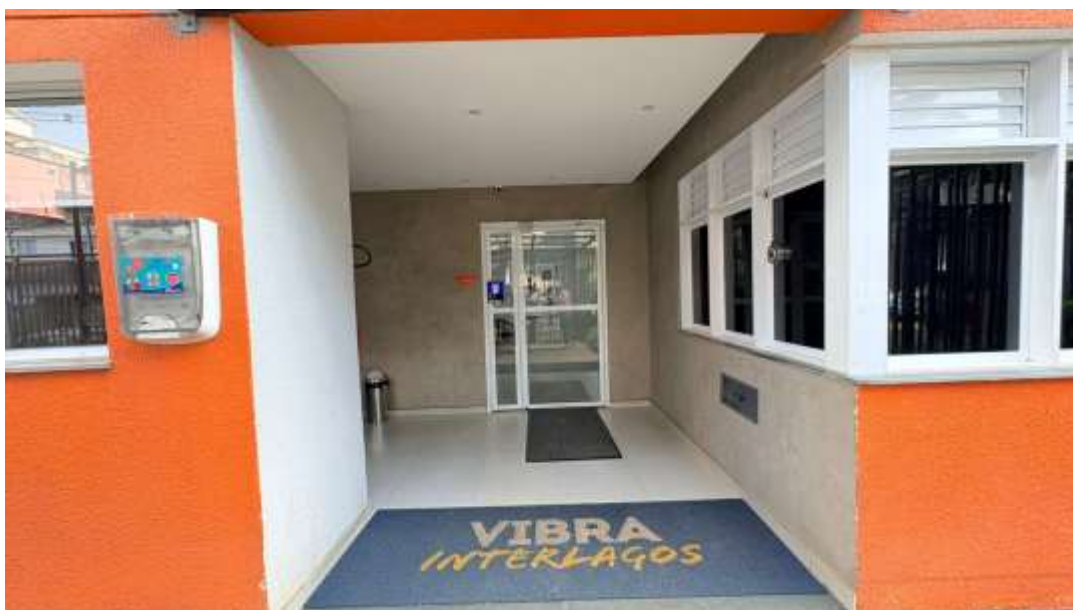
Foto 06 - Hall de entrada
