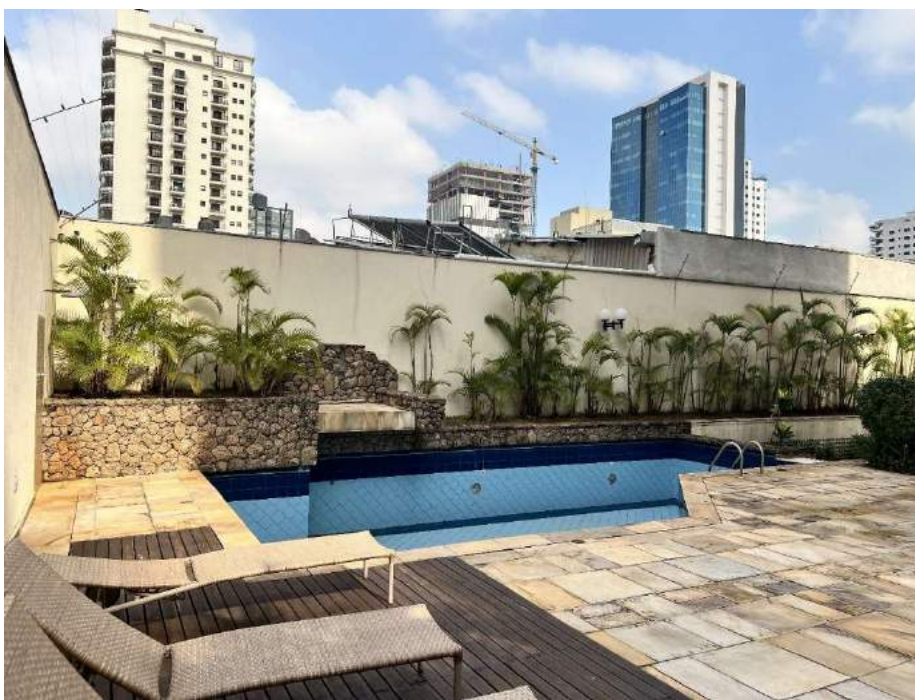
ASPECTOS GERAIS EDIFÍCIO
