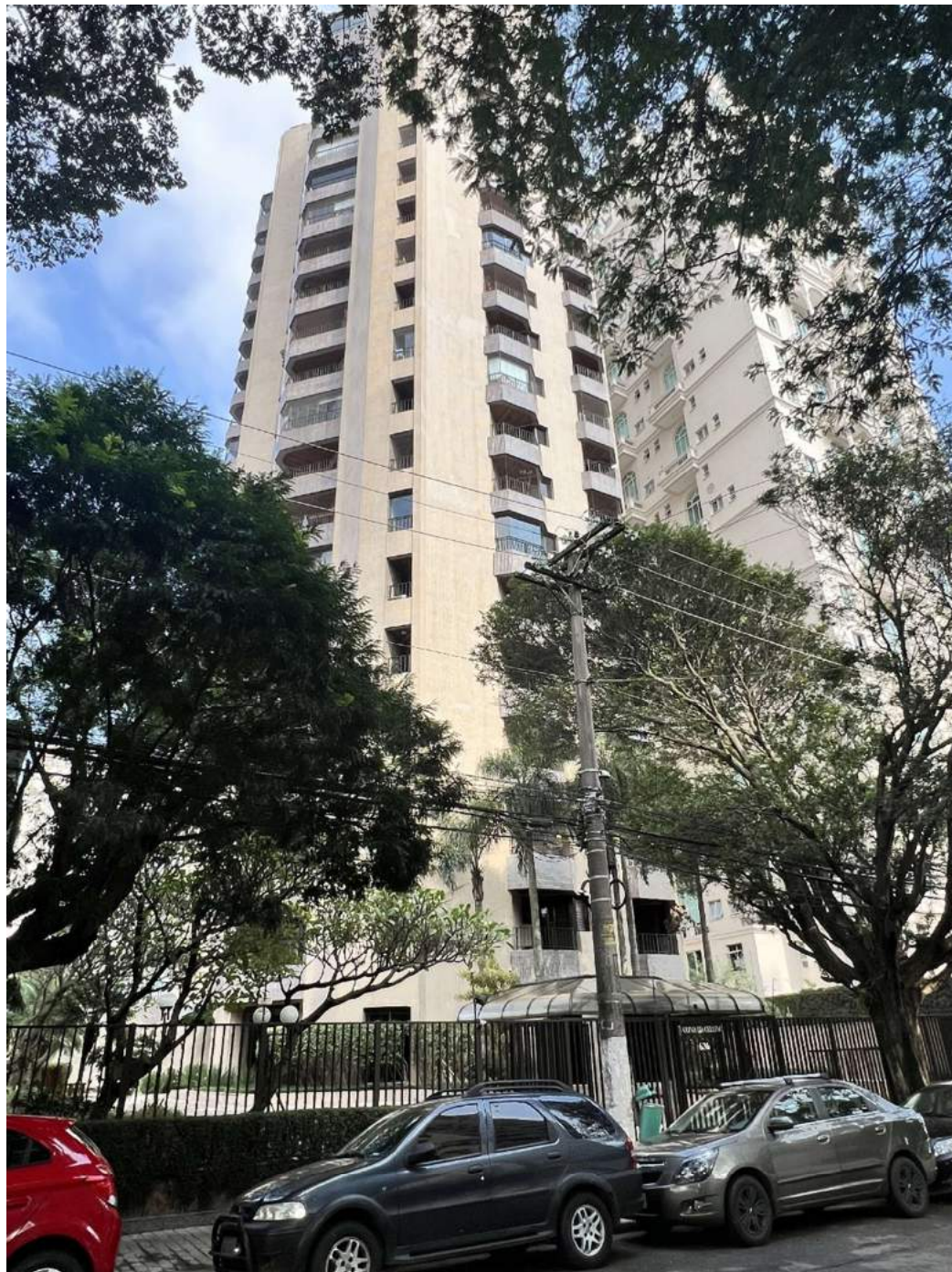
ASPECTOS GERAIS FACHADA – EDIFÍCIO
