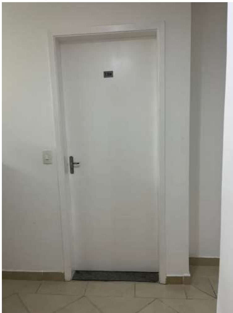
Foto nº. 18 – Vista da porta de entrada.
