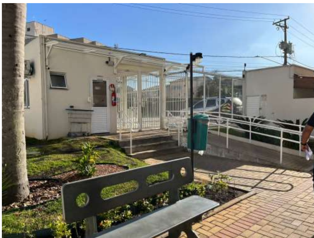
Foto nº. 5 – Vista interna da portaria.
