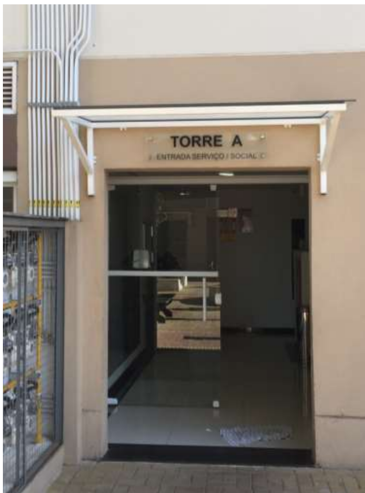
Foto nº. 16 – Vista da entrada do hall de serviço.
