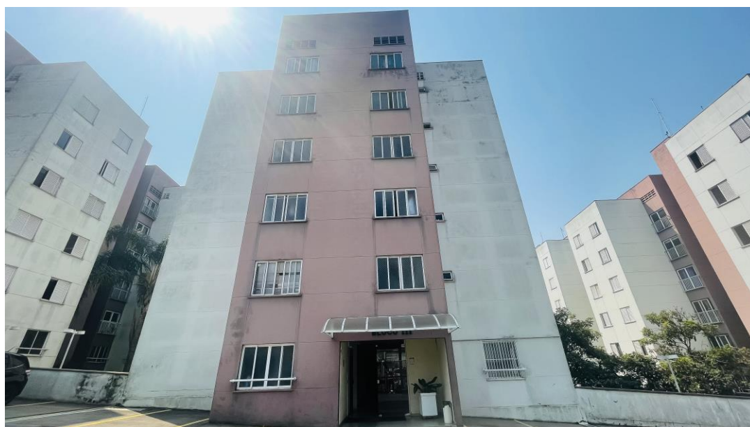
Foto 05 - Fachada Bloco III
