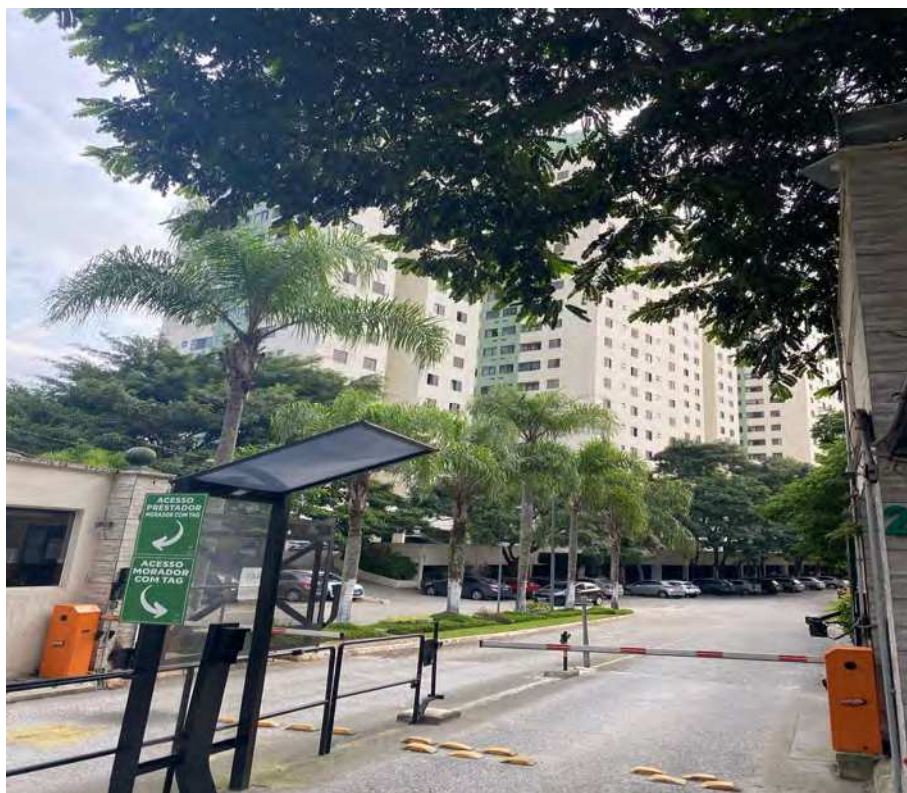
Acima, tem-se outra tomada do referido Condomínio, onde pode-se observar o acesso aos veículos
