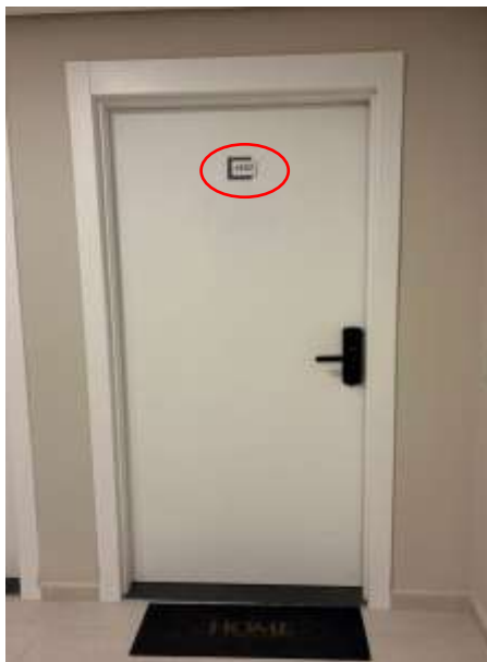
Foto 04 - Entrada do imóvel paradigma
