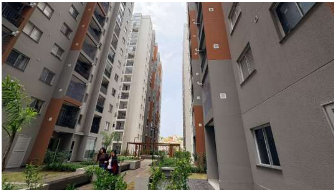
Foto 03 - Vista interna residencial
