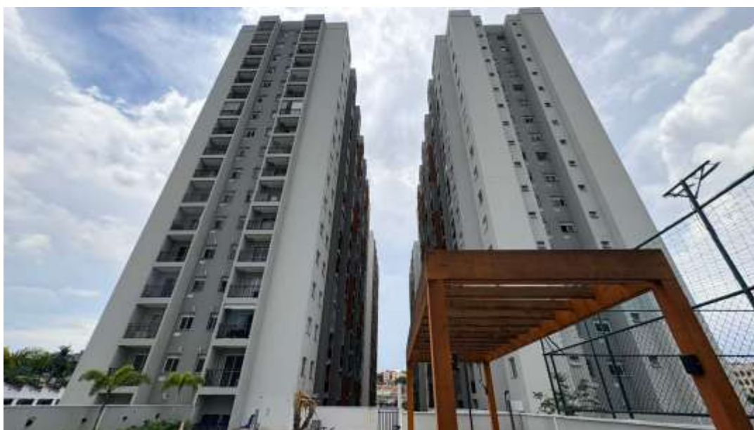
Foto 17 - Vista interna residencial
